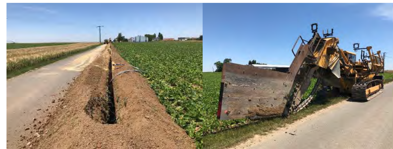
FIGURE 33 – ILLUSTRATIONS DE TRAVAUX REALISES AVEC UNE TRANCHEUSE (SOURCE : ING ENVIRONNEMENT)
