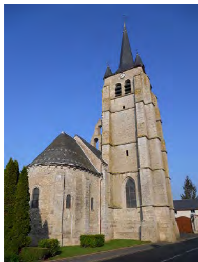
PHOTO 19 - EGLISE SAINT-PIERRE A CORMAINVILLE
